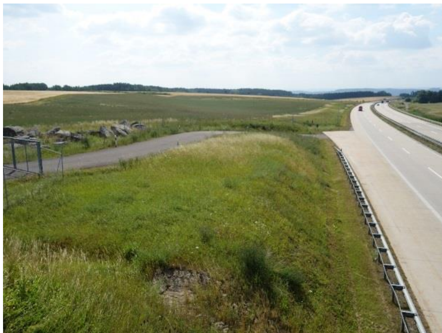
Blick auf die Rastanlagen-Ostseite (von der Feldweg-ÜF) in Richtung Süden
