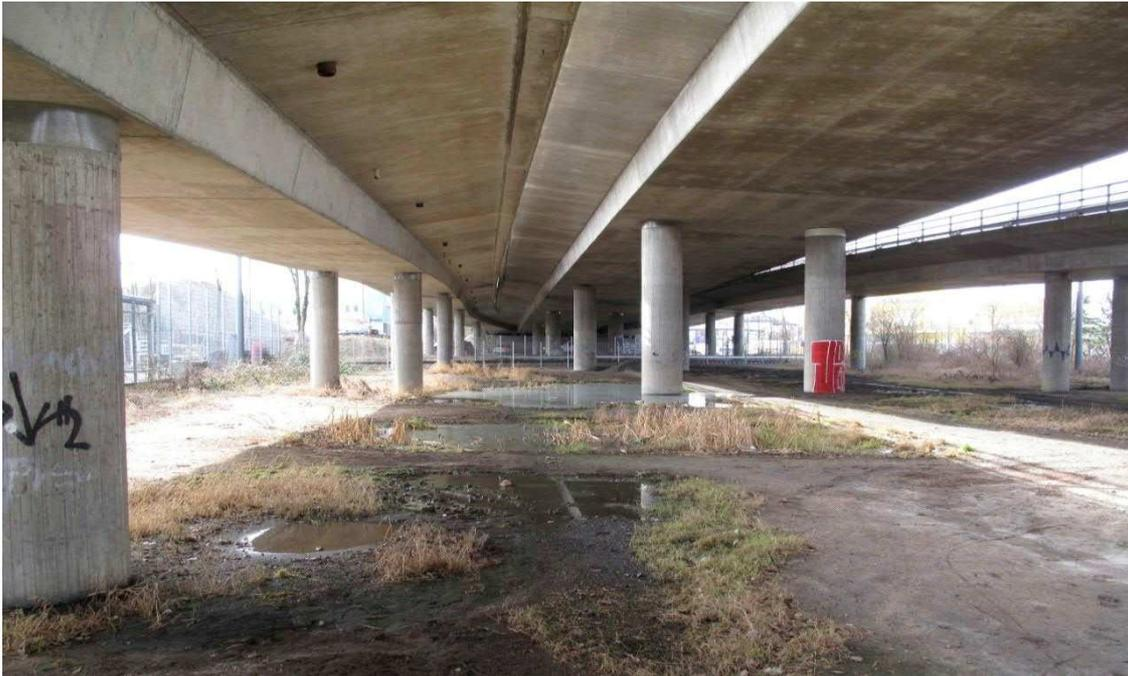
**Abbildung 1:** Entwässerung mittels Fallrohre / „Pfützenbildung“ unterhalb der Hauptbrücke
