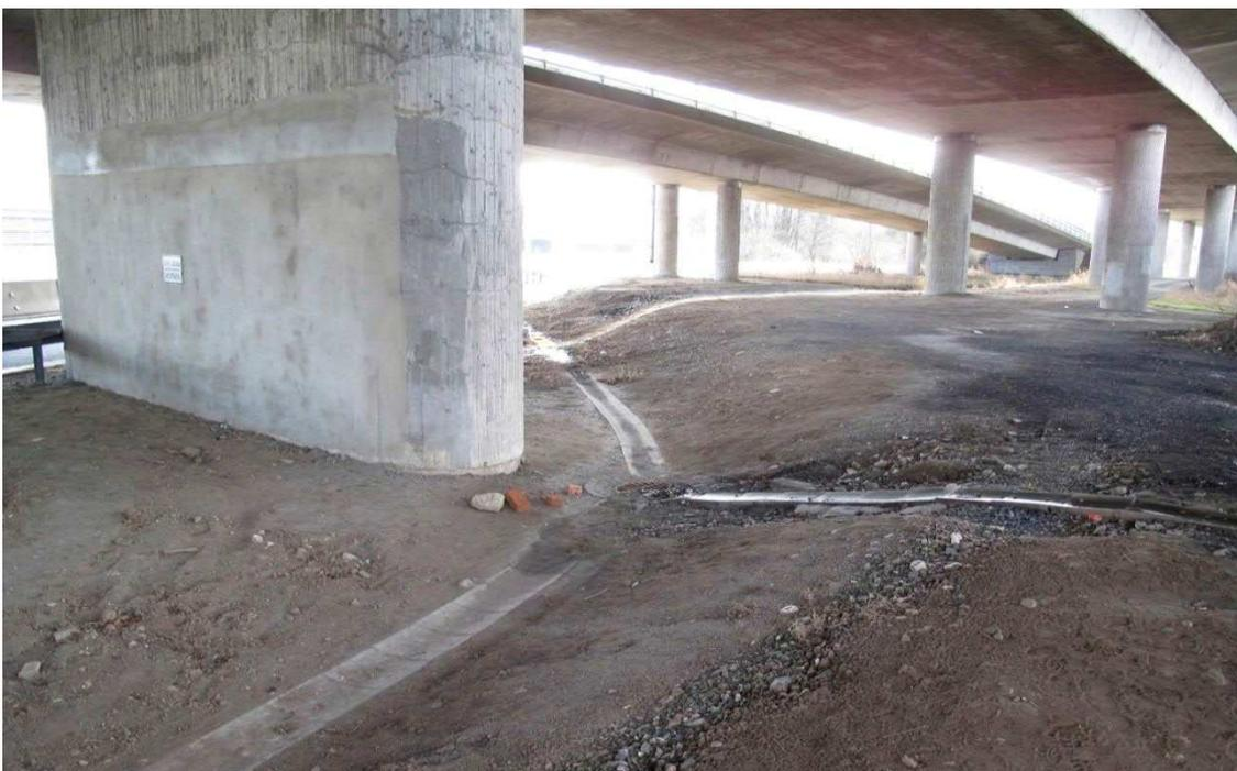
**Abbildung 2:** Entwässerungssystem unter der Brücke
