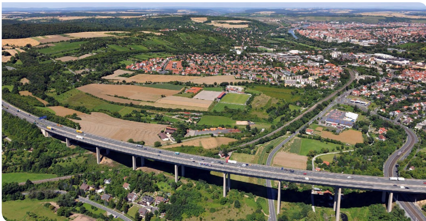
Bestehende Talbrücke Heidingsfeld, im Hintergrund die Stadt Würzburg
