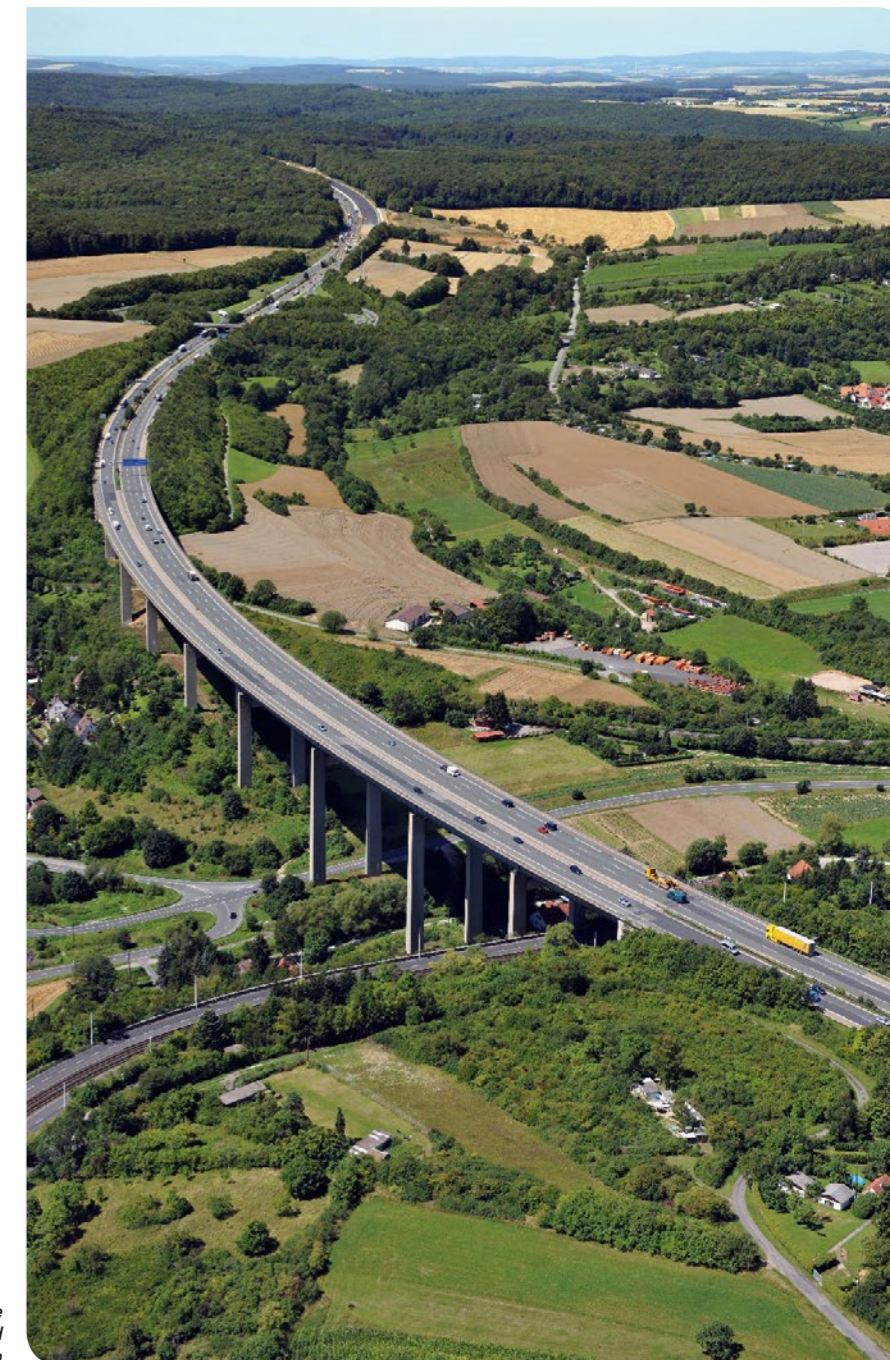
Blick auf die bestehende Talbrücke Heidingsfeld in Richtung Westen
