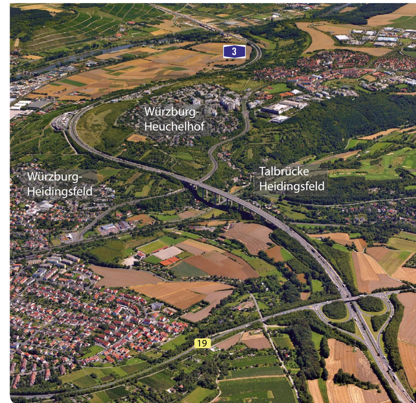
Blick auf die bestehende A 3 mit Talbrücke Heidingsfeld in Richtung Osten
