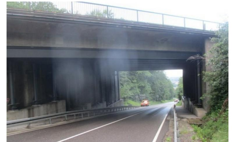
Unterstützungsstruktur zur Erhöhung der Traglast:
