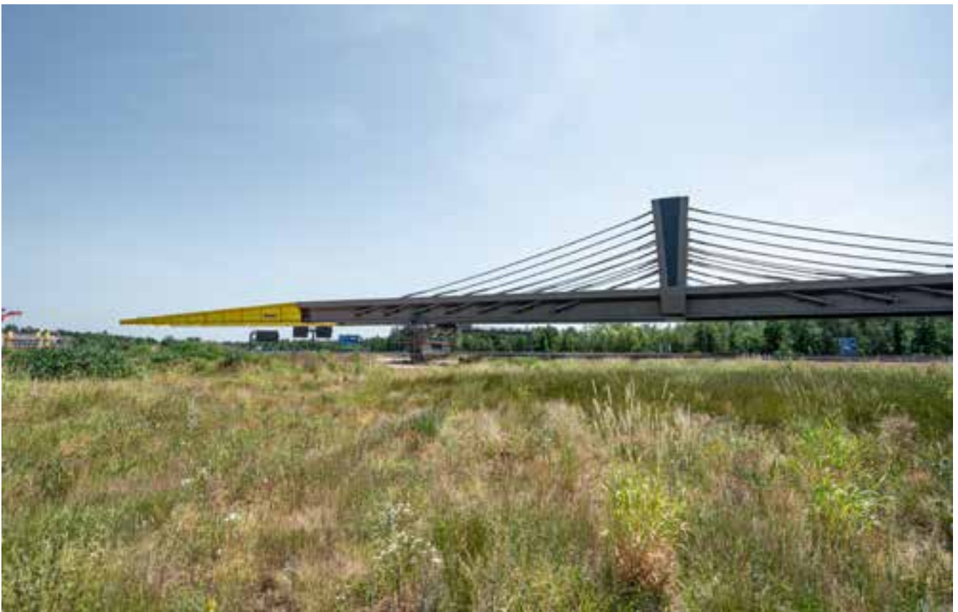
Bild 33: Verschubtakt 3 - Seitenansicht
