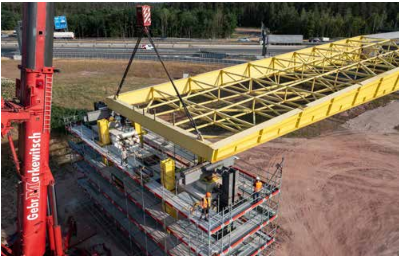
Bild 35: Verschubtakt 3 - Luftbild Auffahren Verschubwippe Achse 3
