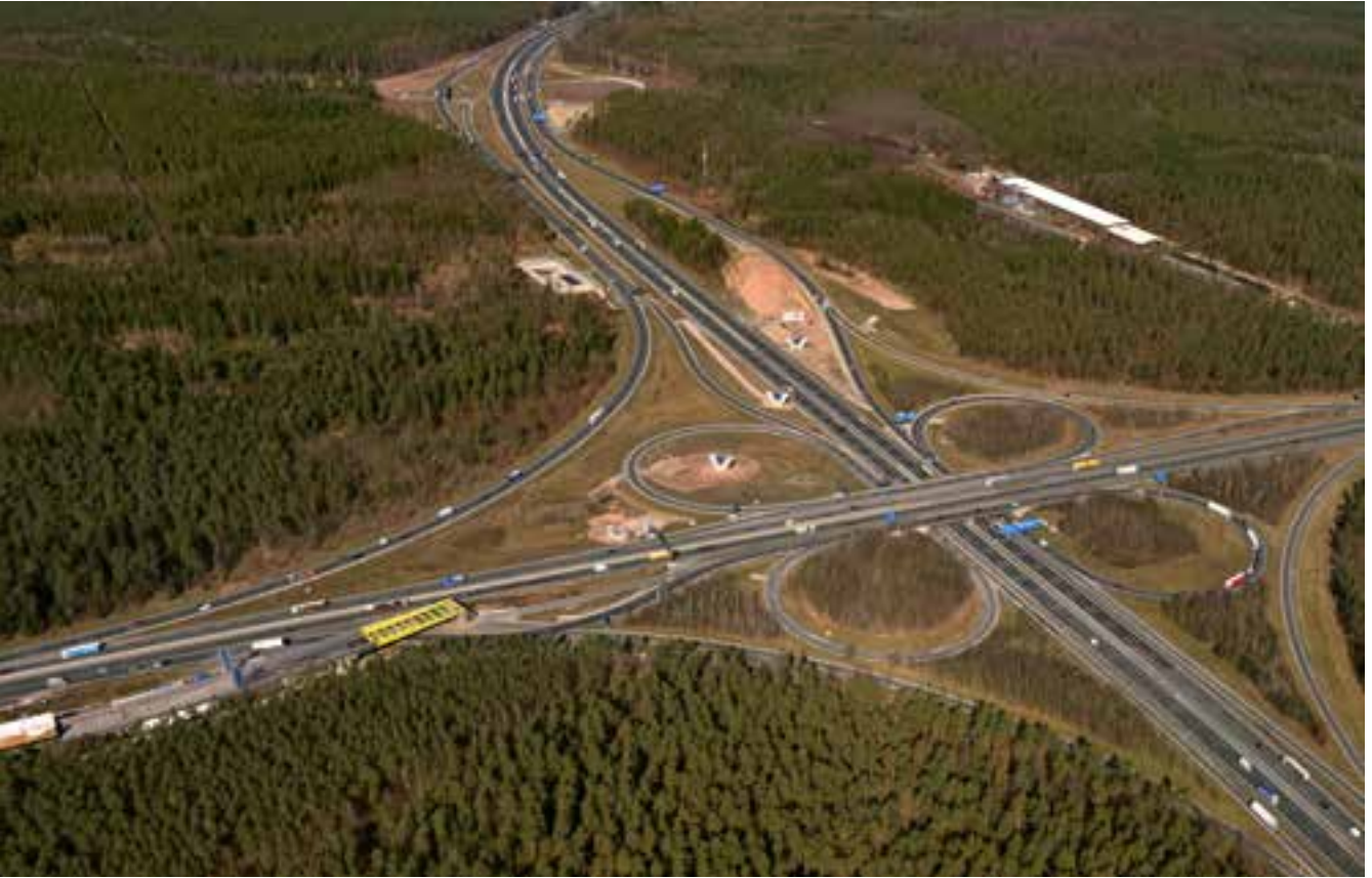
Bild 14: Luftbild Autobahnkreuz Nürnberg- Ost
