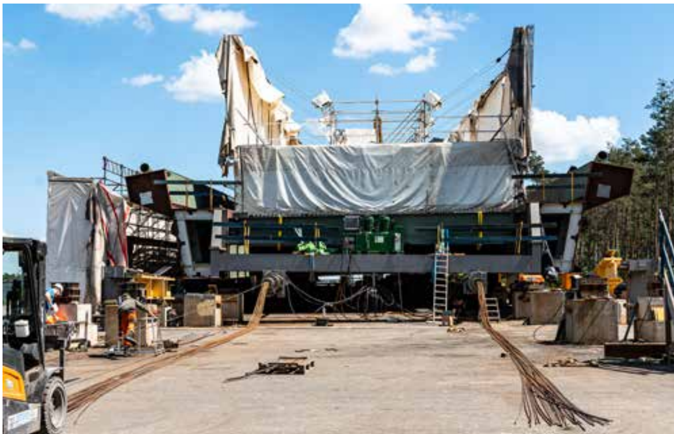
Bild 46: Verschubtakt 5 - Taktende im Taktkeller
