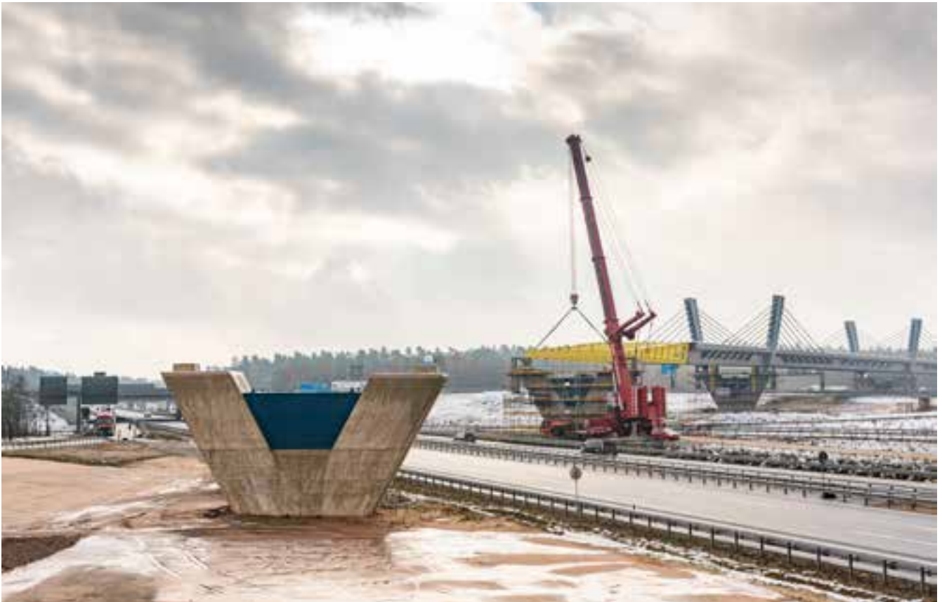
Bild 44: Verschubtakt 4, Tag 2 - Ansicht von Pfeilerachse 5
