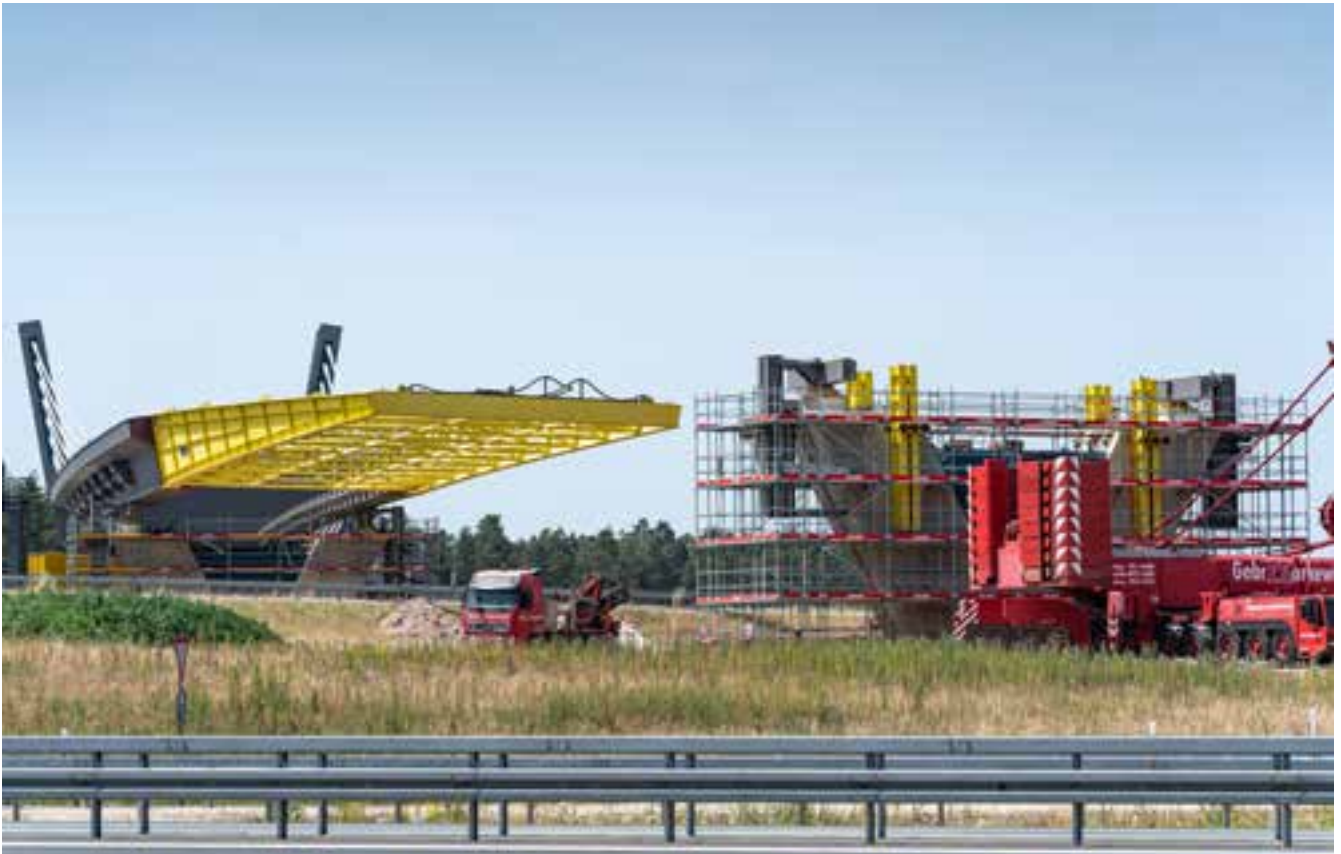
Bild 32: Verschubtakt 3 - Ansicht von Pfeiler 3
