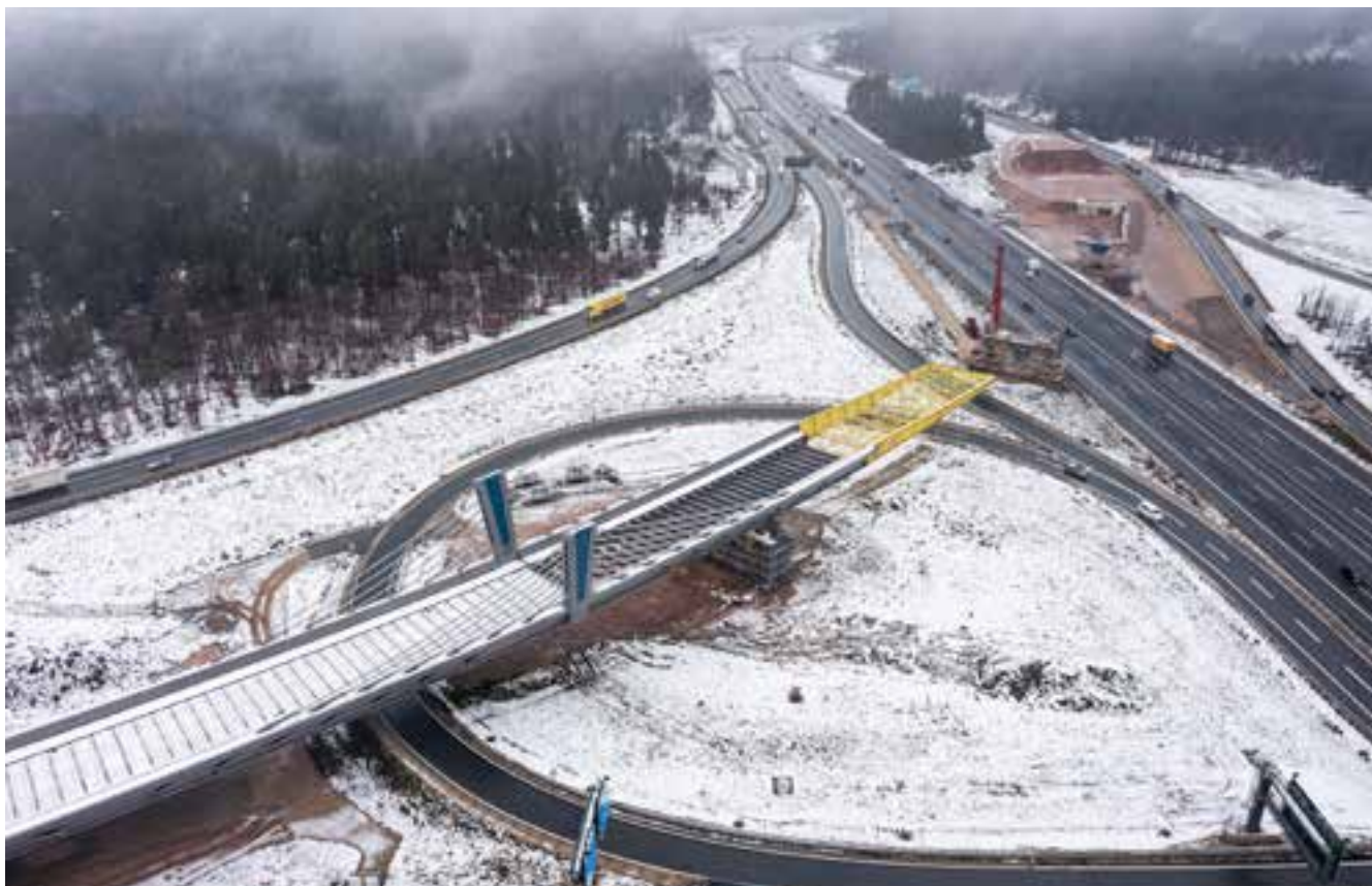
Bild 38: Verschubtakt 4, Tag 1 - Luftbild Blickrichtung Nordwest
