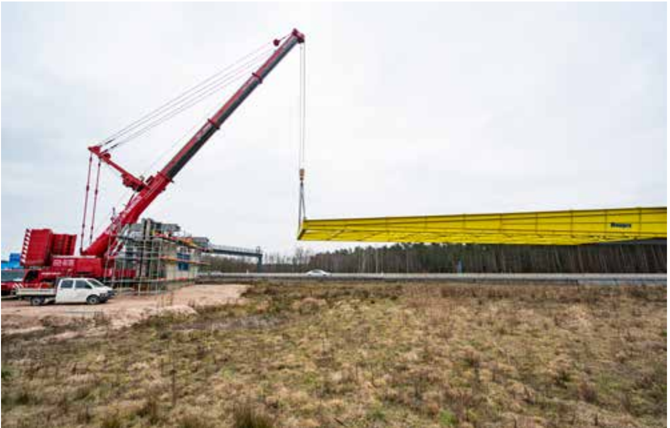
Bild 26: Verschubtakt 2 mit Kranführung, Tag 2
