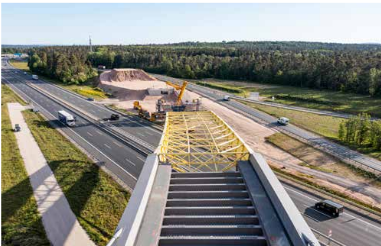
Bild 47: Verschubtakt 5 - Luftaufnahme vorderes Verschubfeld mit Vorbauschnabel
