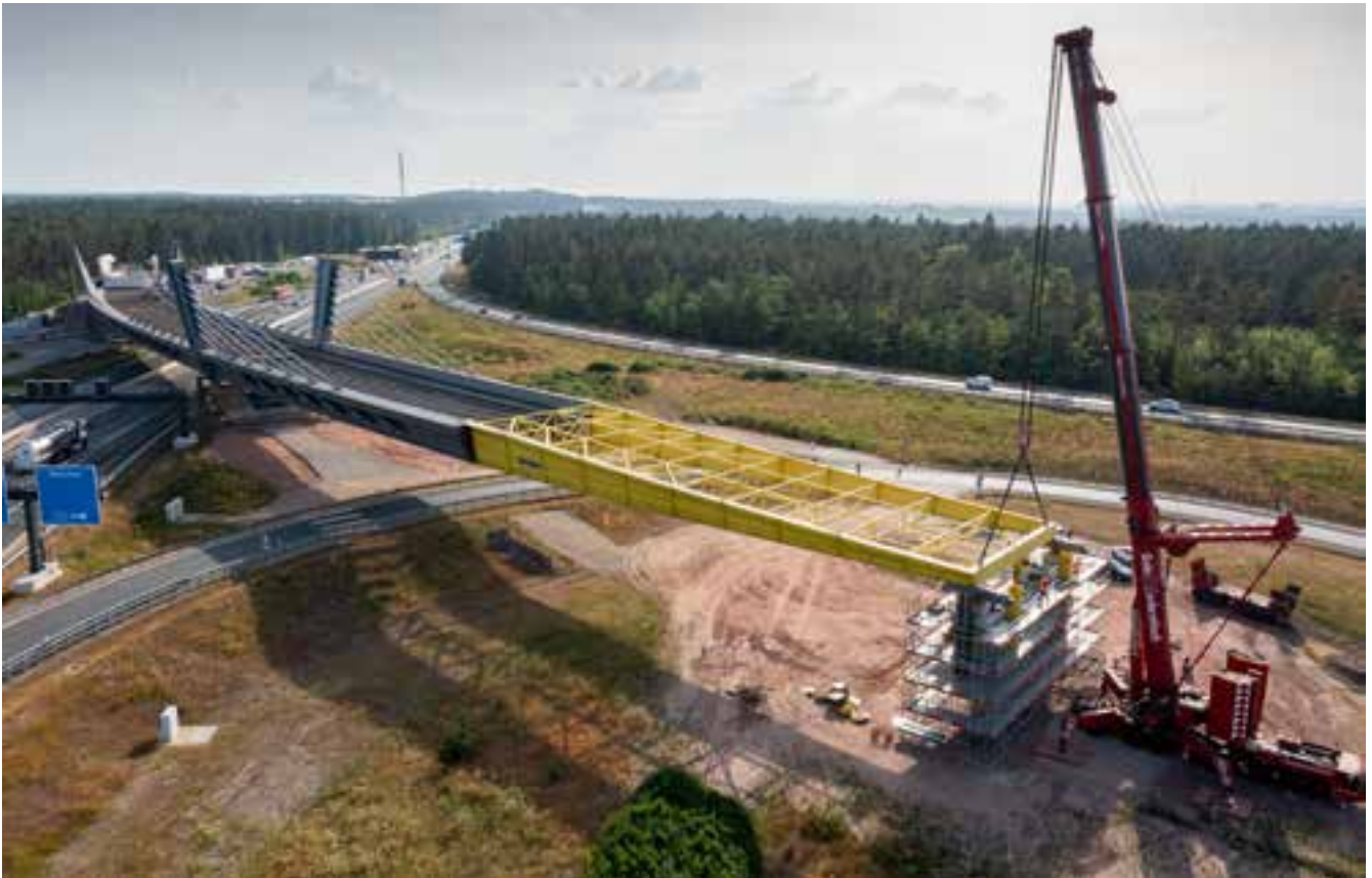
Bild 34: Verschubtakt 3 - Luftbild Pfeilerachse 3, Blickrichtung Nürnberg
