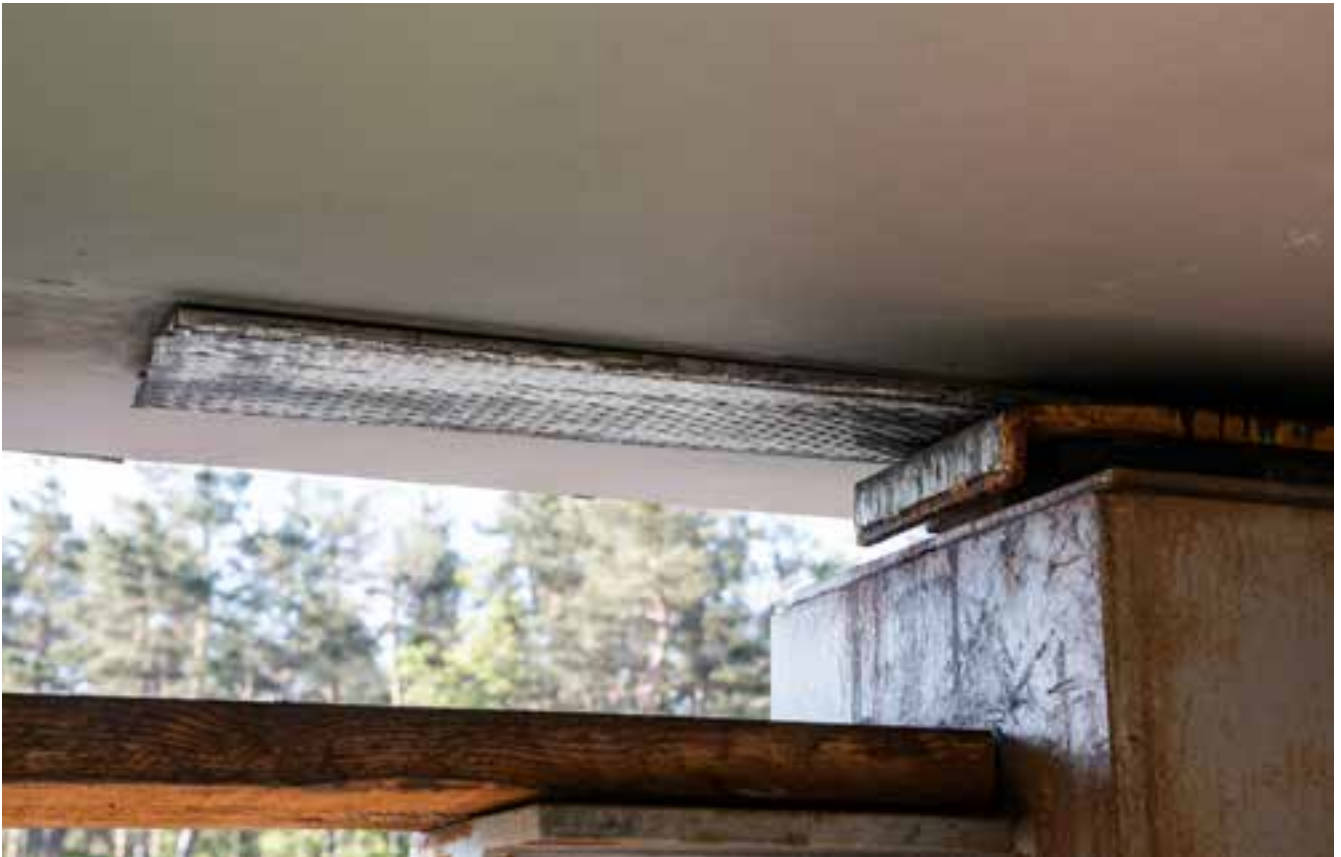
Bild 48: Verschubtakt 5 - Verschublager mit Teflongleitplatte
