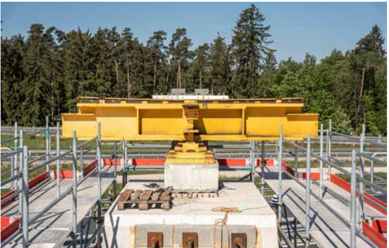
Bild 49: Verschubtakt 5 - Verschubwippe Achse 5
