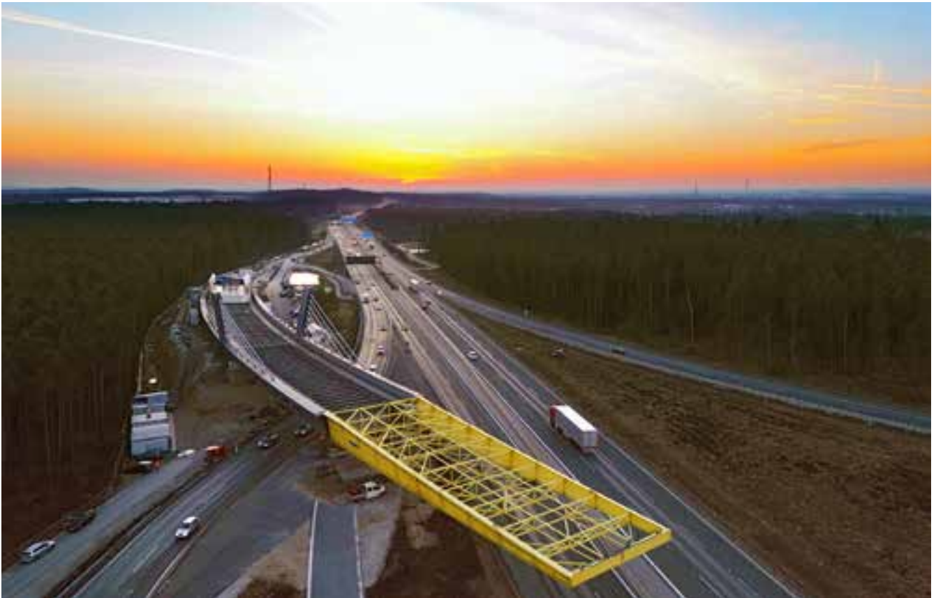
Bild 24: Verschubtakt 2, Tag 1
