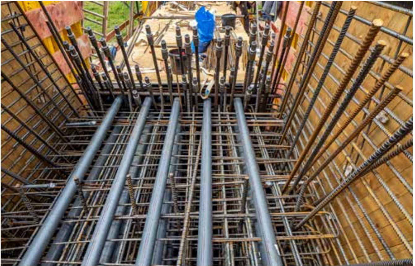
Bild 16: Bewehrung Pfeilerkopf mit Querspanngliedern
