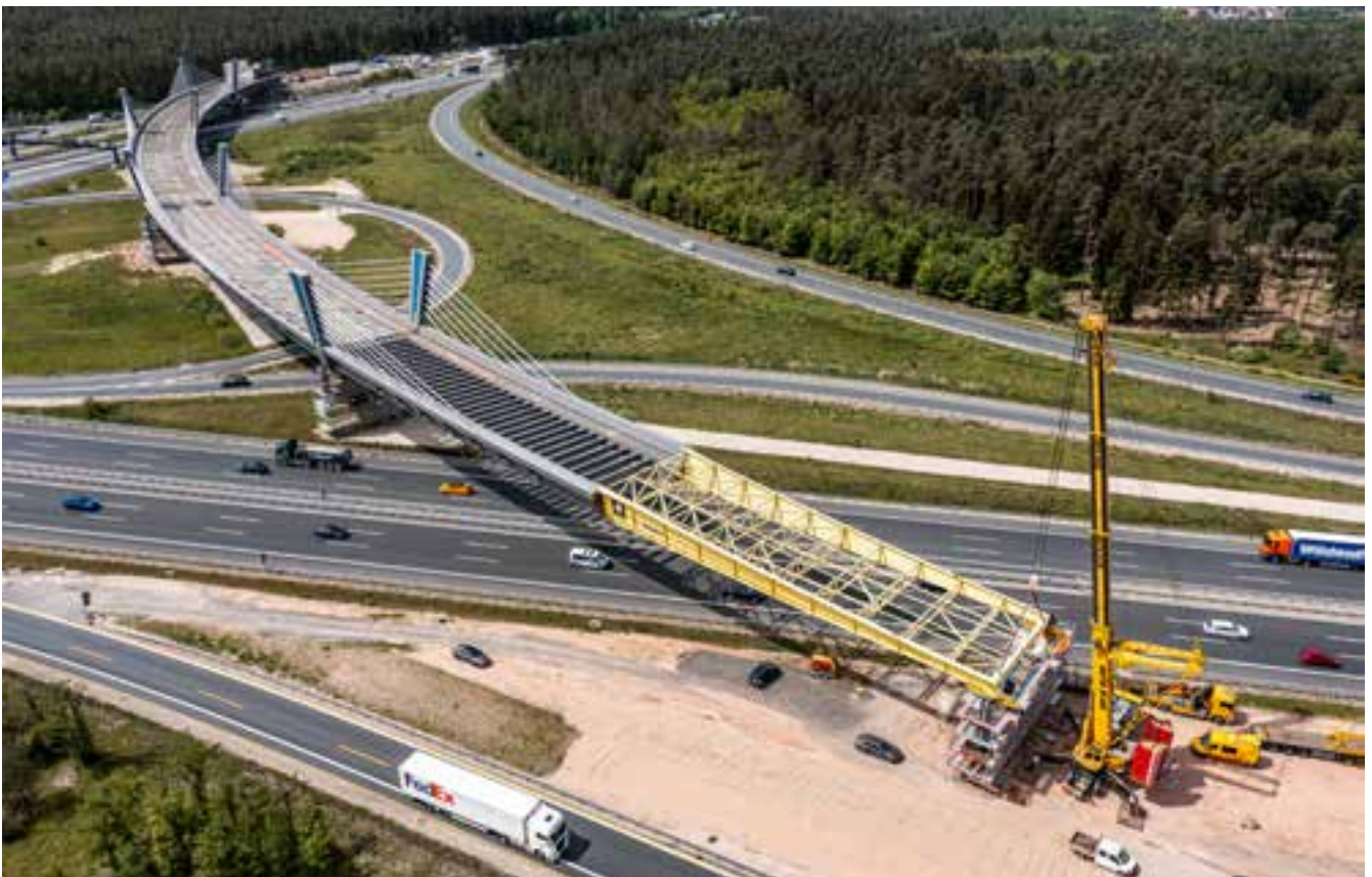
Bild 53: Verschubtakt 5 - Einfahren auf Pfeilerachse 5
