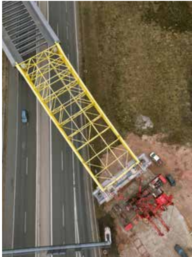
Bild 28: Verschubtakt 2 - Draufsicht Pfeilerachse 2
