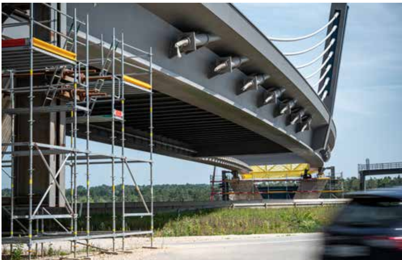
Bild 31: Verschubtakt 3 - Tag 1
