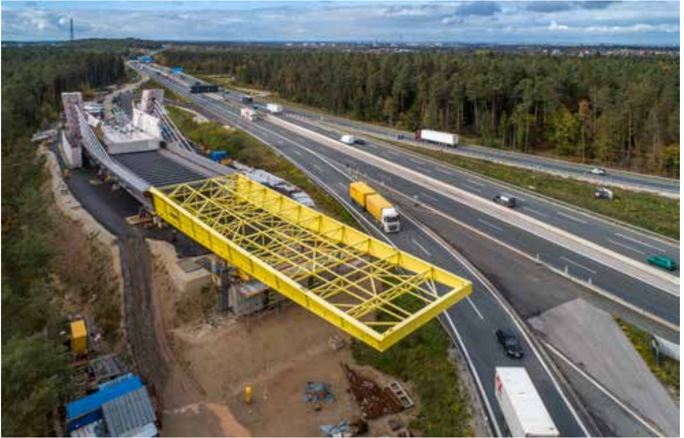
Bild 18: Taktkeller Vorderansicht
