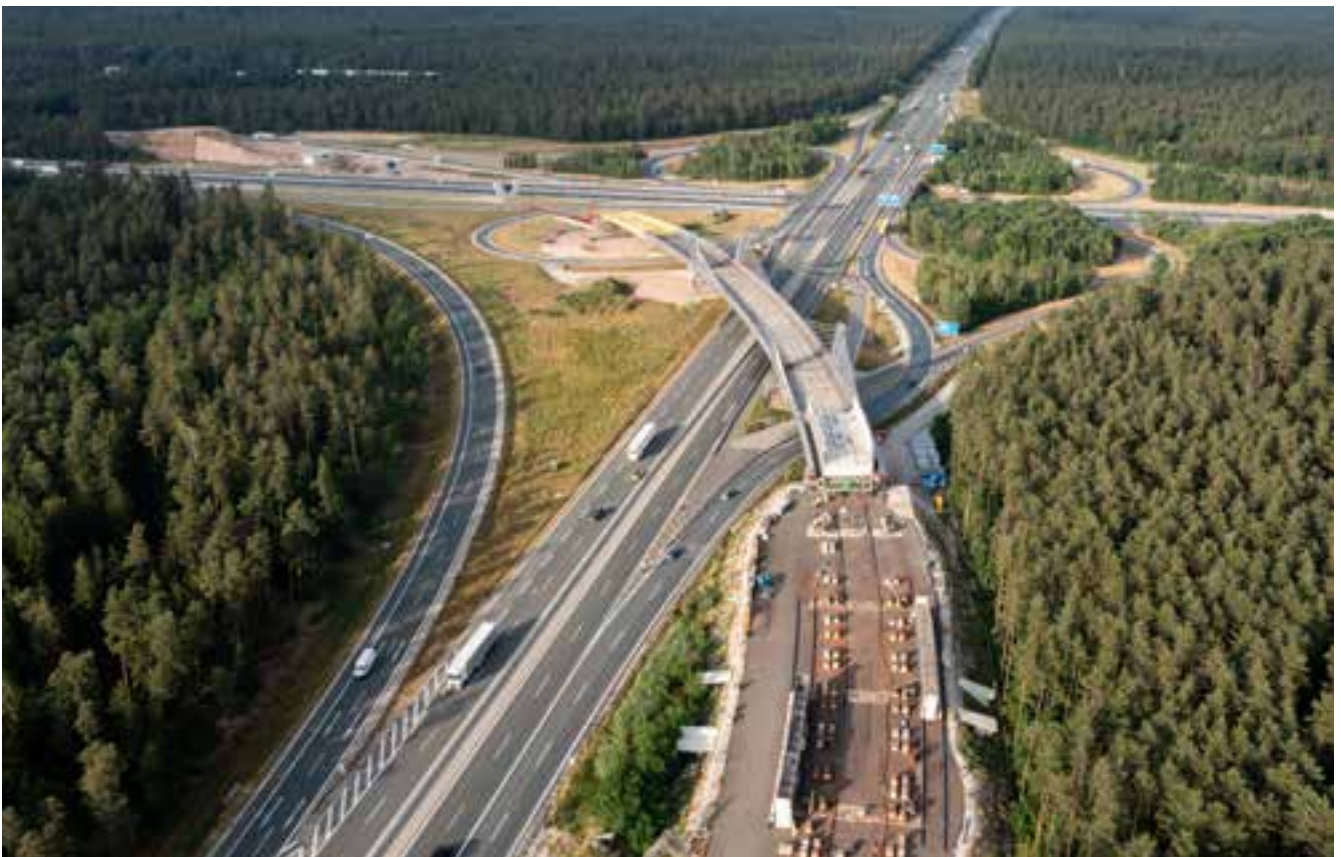
Bild 37: Vershubtakt 3 - Luftbild Blickrichtung Osten
