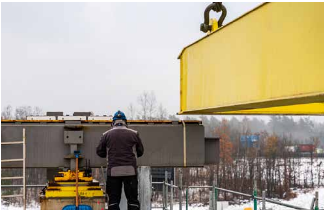
Bild 43: Verschubtakt 4, Tag 2 - Auffahren auf Verschubwippe
