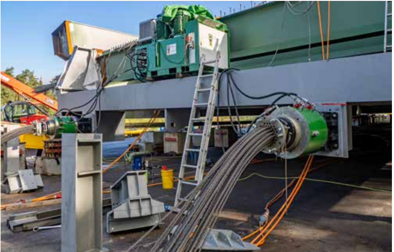
Bild 20: Verschubanlage
