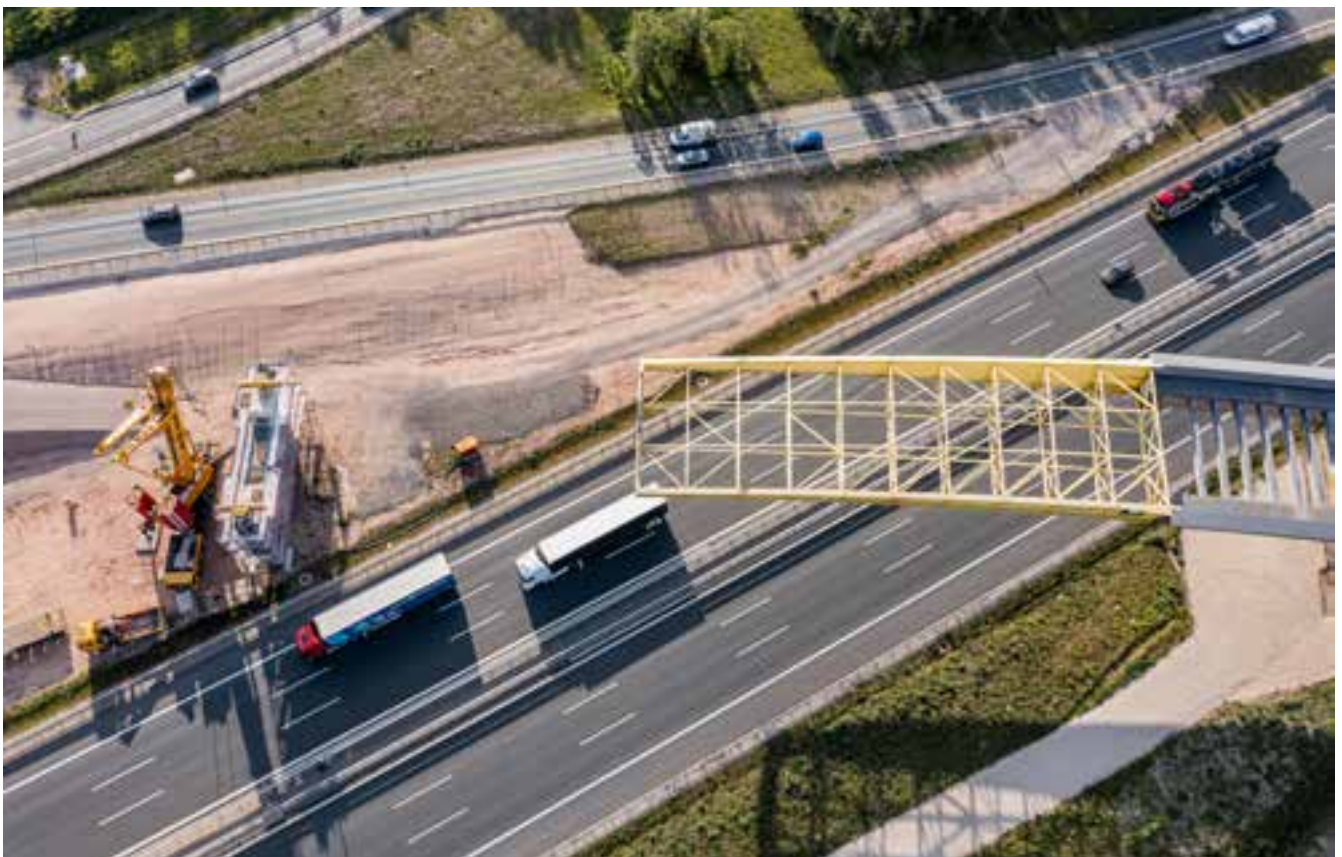
Bild 51: Verschubtakt 5 - Luftaufnahme über A9
