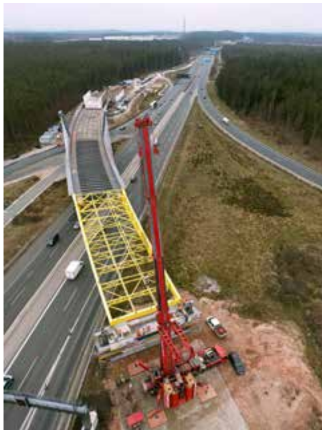
Bild 29: Verschubtakt 2 - Luftbild Vorderansicht auf Taktkeller
