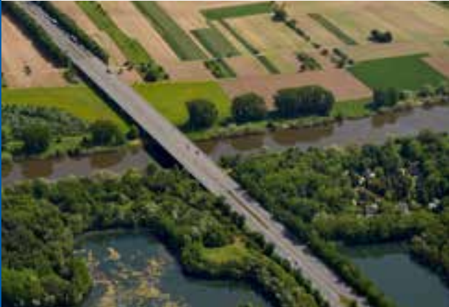
Foto des bestehenden Bauwerks
