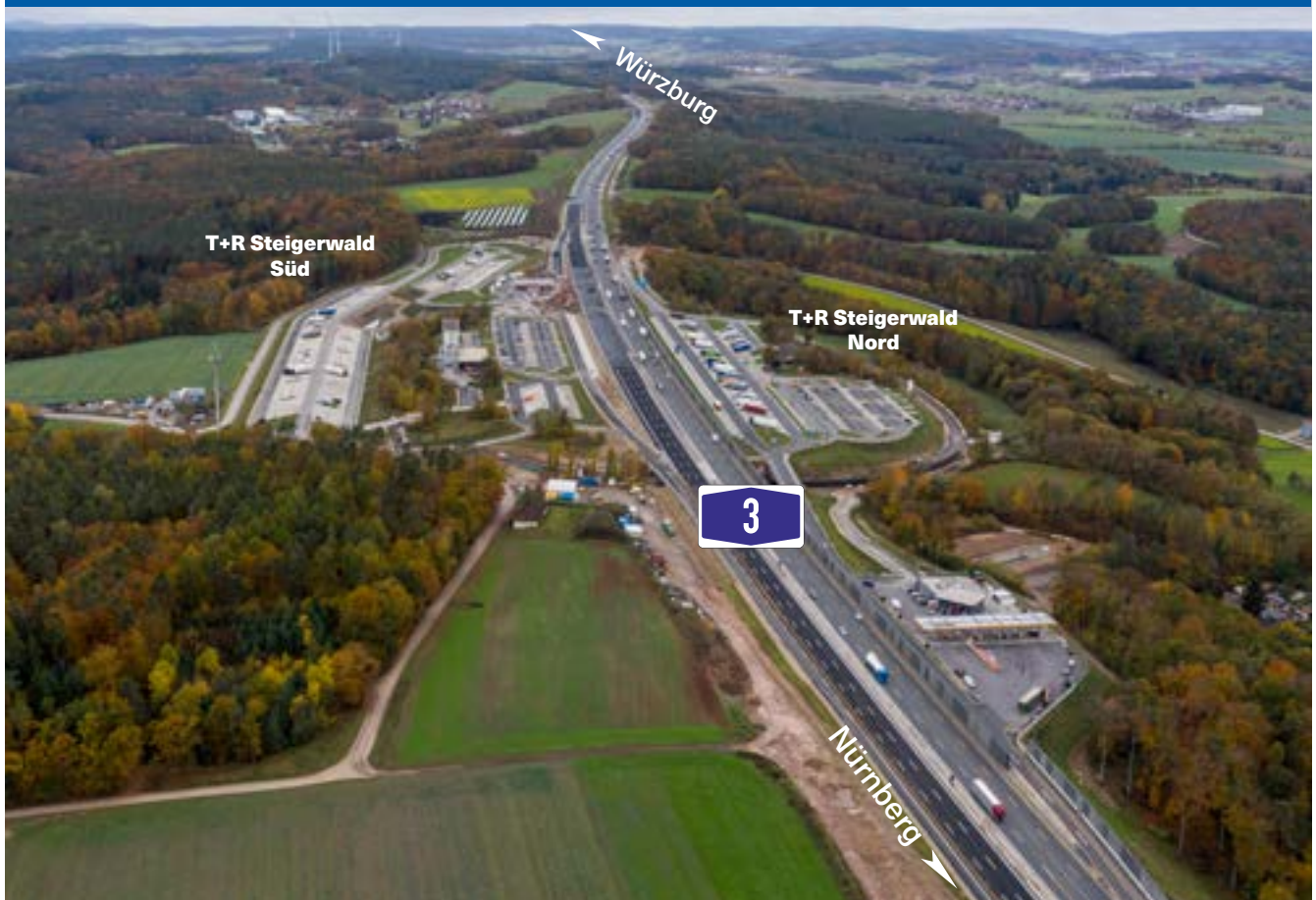
Bauarbeiten an der Tank- und Rastanlage Steigerwald
