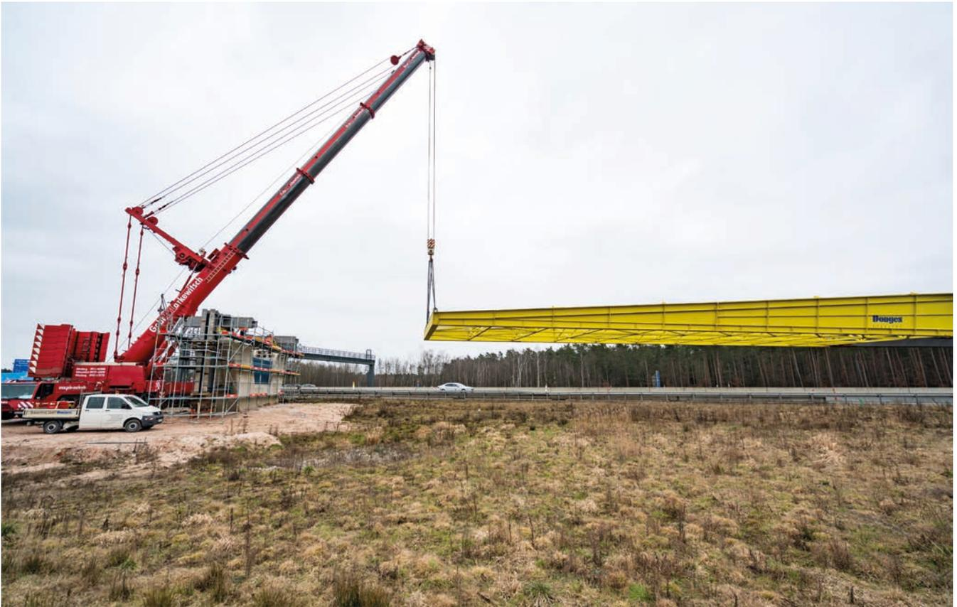
*Bild 26: Verschubtakt 2 mit Kranführung, Tag 2*
