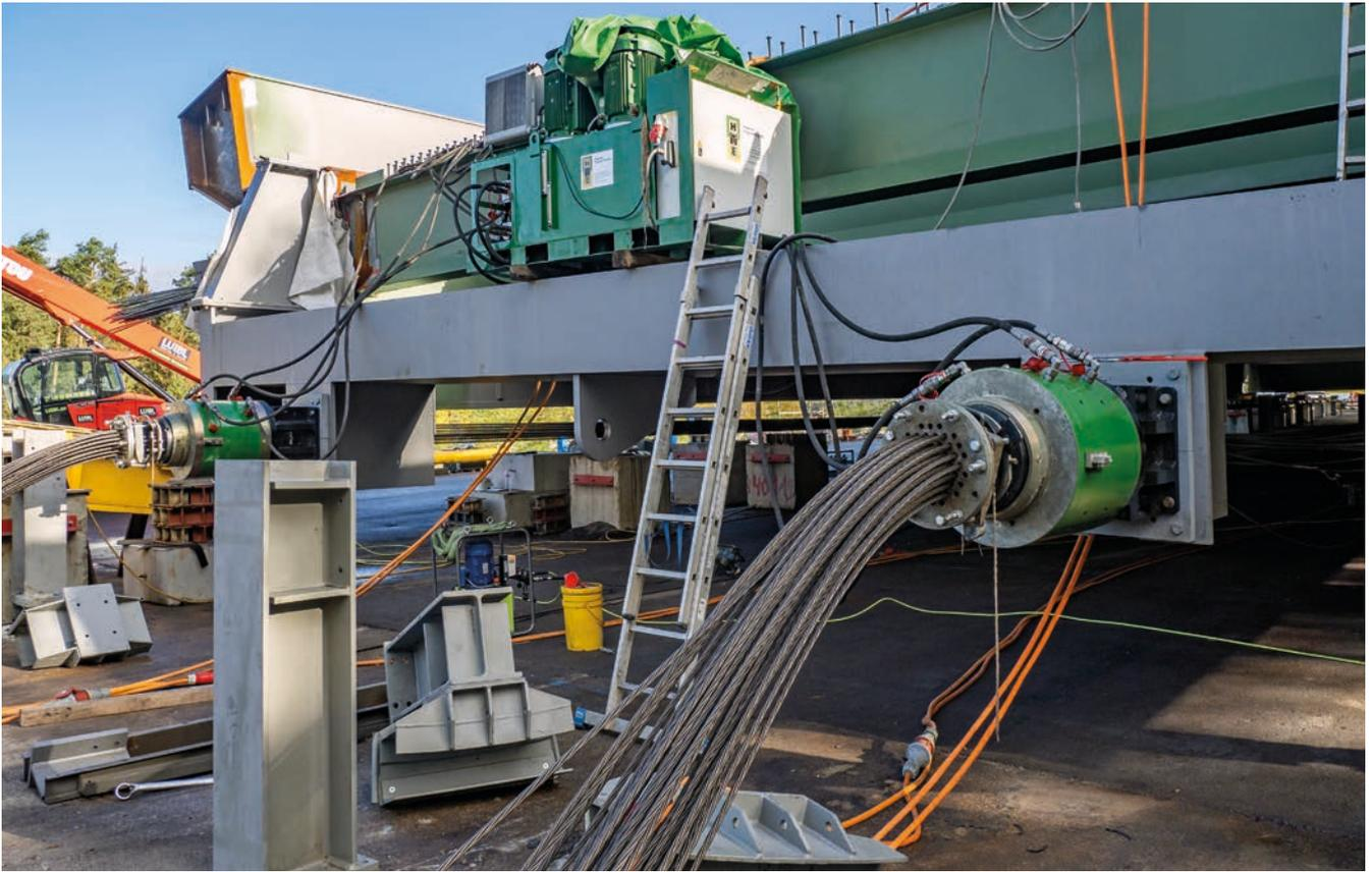
*Bild 20: Verschubanlage*
