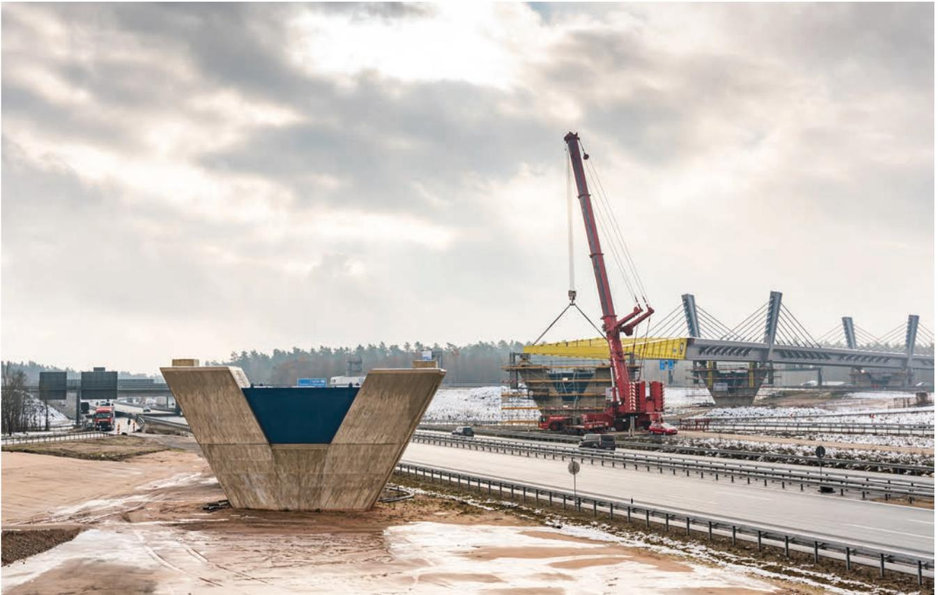
Bild 44: Verschubtakt 4, Tag 2 - Ansicht von Pfeilerachse 5
