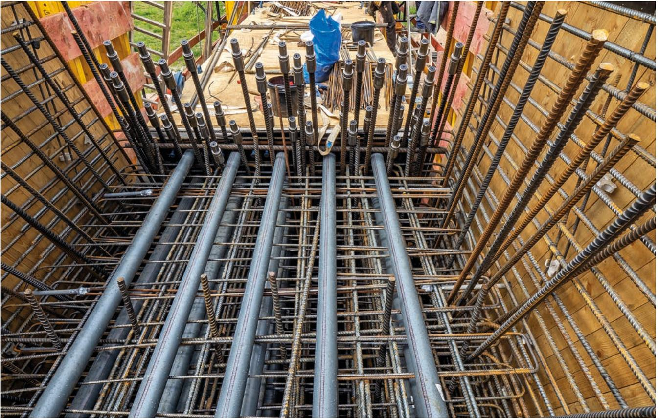
*Bild 16: Bewehrung Pfeilerkopf mit Querspanngliedern*
