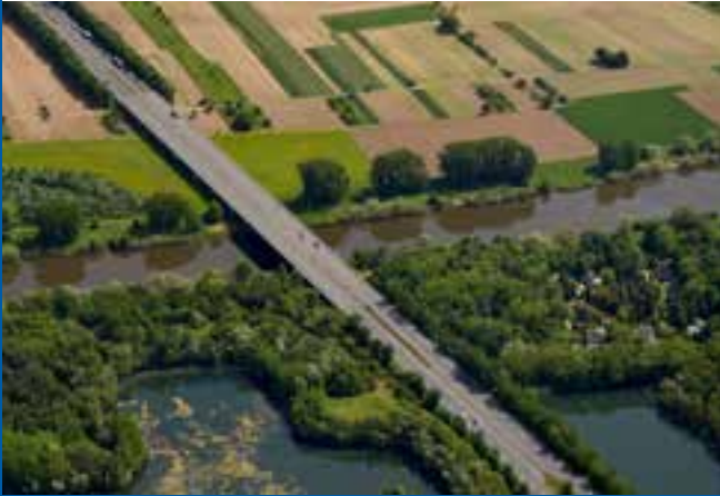
Foto des bestehenden Bauwerks
